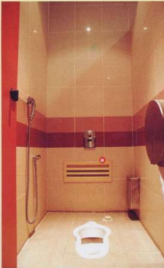
a. Intake Grilles
